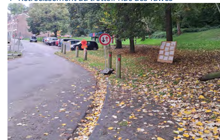
6 - Absence de trottoir Rue Jean Haust
